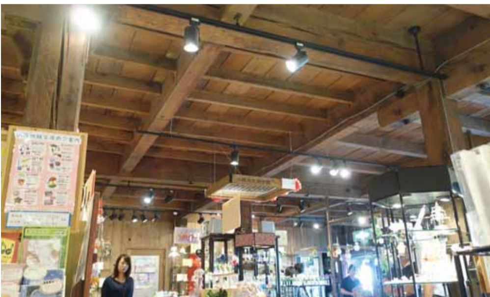
内観（びーどろ館）
