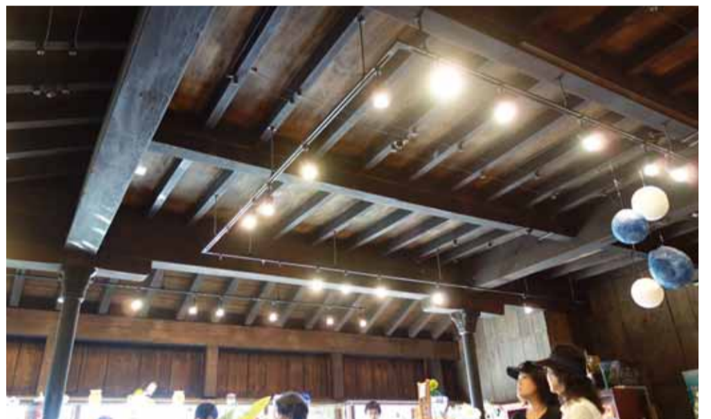
碍子引き配線残る本館
