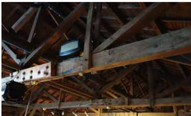
音響・ダクト・配線の梁を利用
