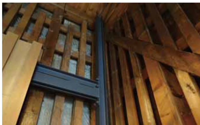
柱と梁補強
