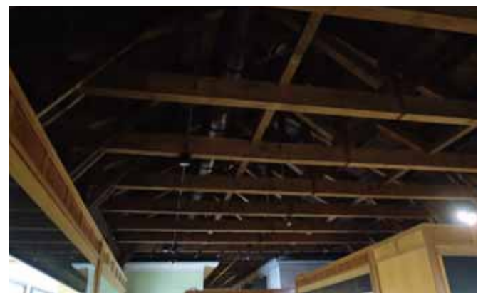
梁・配線・ダクト
