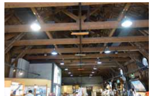
梁を生かした売店
