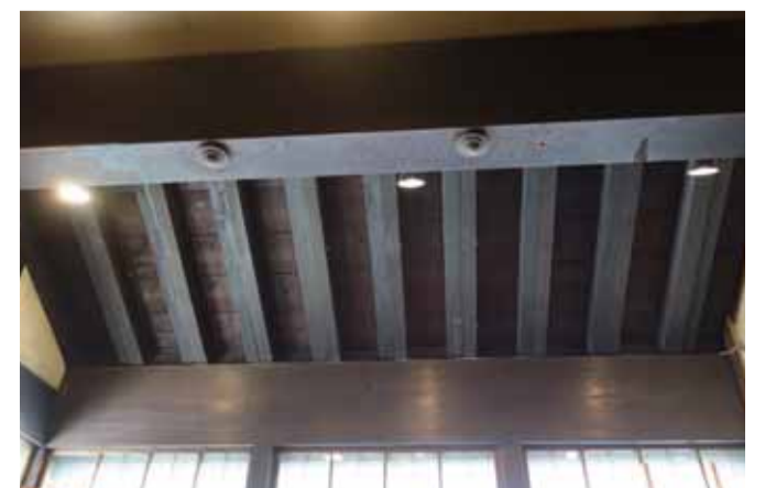
梁をオイルステン塗り
