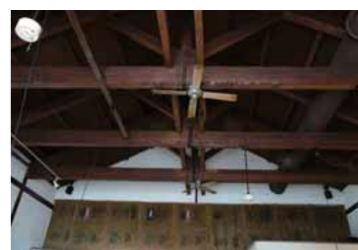
梁とダクトの素朴なコントラスト
