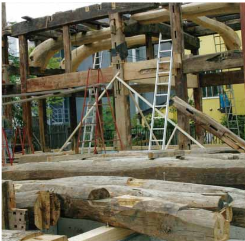
マオイ酪農会館解体工事
