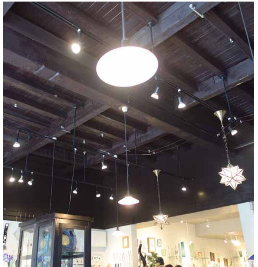
梁と碍子引き配線を生かした店内
