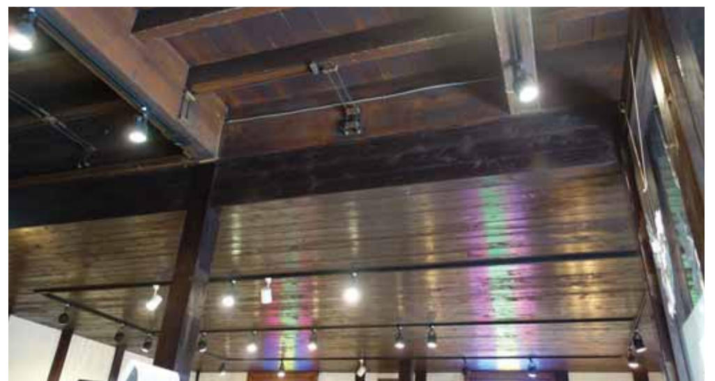
柱と梁を生かして張り替え
