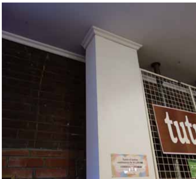
煉瓦壁露出がいい
