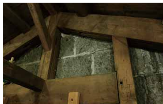
梁と石壁を生かす
