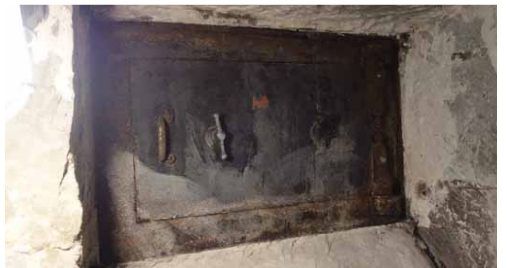
開かずの扉（金庫）
