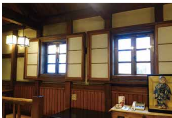
石蔵2階の漆喰壁と障子
