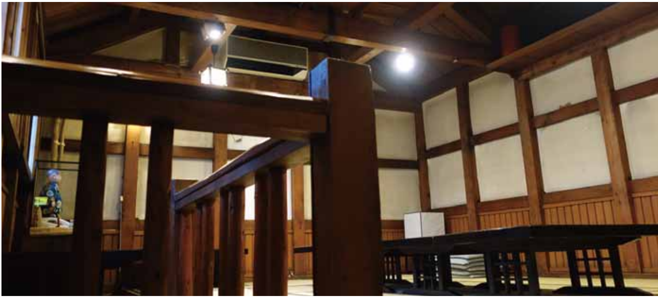
石蔵2階の堅牢な梁
