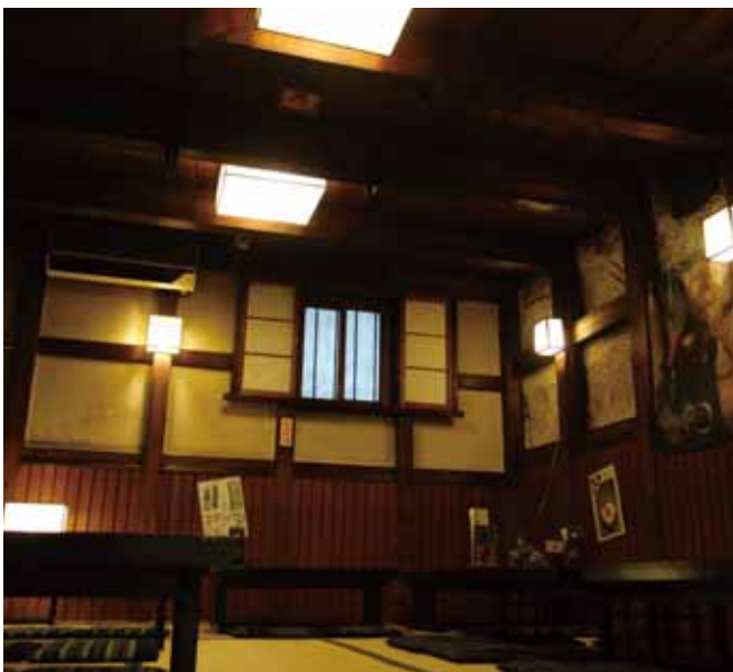
石壁・漆喰壁・腰板の三拍子
