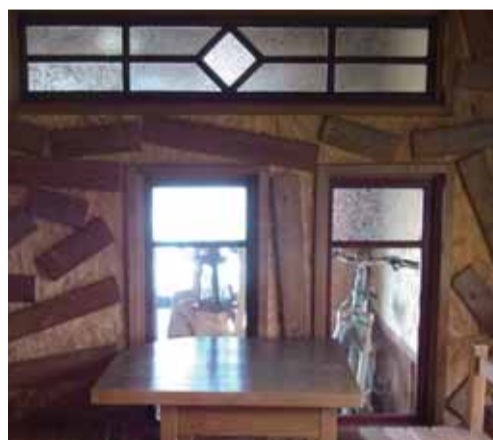
建具・窓ガラス
