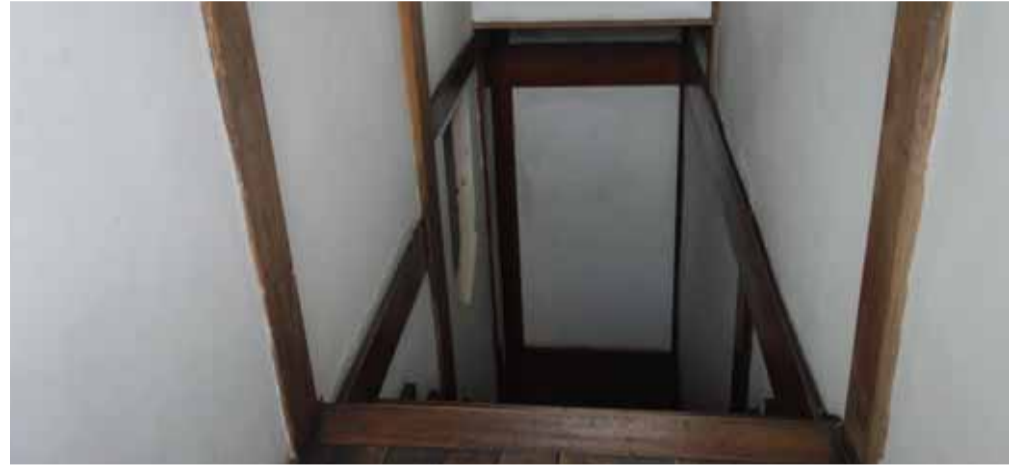
漆喰壁の階段
