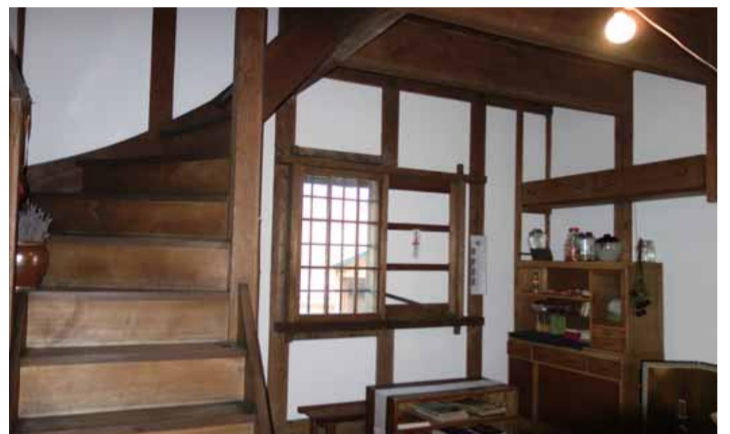
漆喰壁の蔵内部
