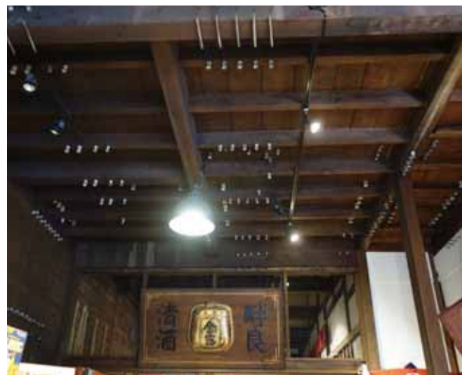
碇子（がいし）引き電気配線
