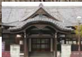
小樽市 公会堂（旧小樽区公会堂）
