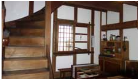
漆喰壁の蔵内部
